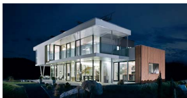
Einfamilienhaus, Typ BOX
